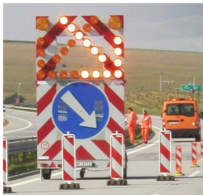
Obr. 2. I provozní údržba může znamenat komplikace na trase.
