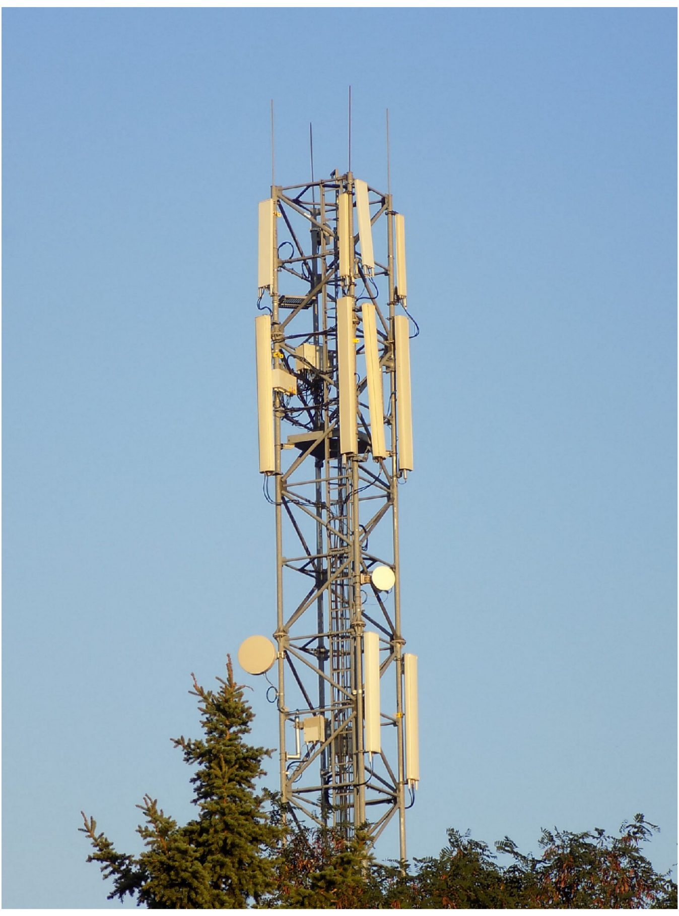
Anténní systémy základnové stanice
