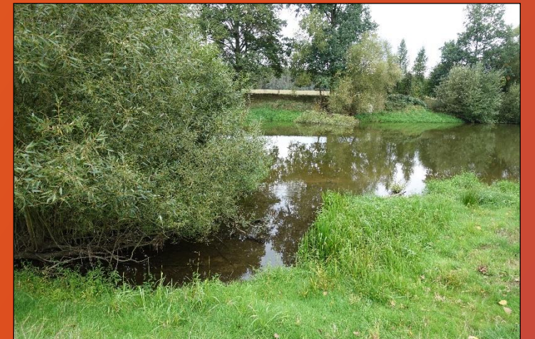
objekt vypouštění ČOV Roudná
