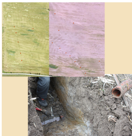
Obr. 1. Odkop drénu dle identifikace na snímcích pořízených UAV.
