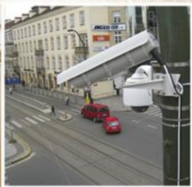
KAMEROVÉ SYSTÉMY CCTV SYSTEMS
