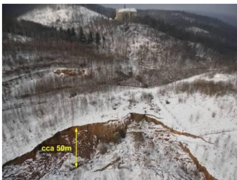
Obr. 9 Sesuvy na pilíři ochraňujícím zámek [7]
