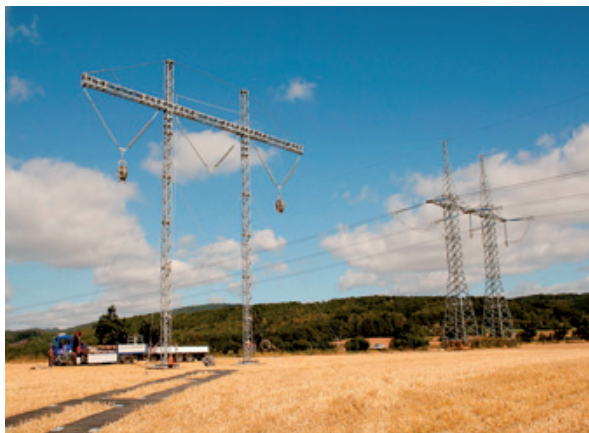
Obr. 2. Ukázka dokončené stavby stožáru energetické sítě (zdroj: ČEPS, a.s.).
